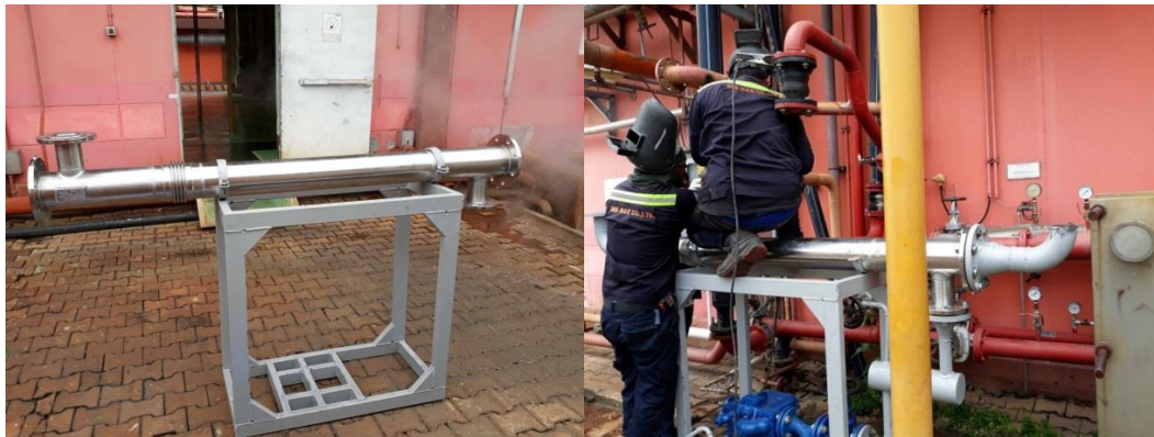
ภาพที่ 11 ทำการติดตั้งเครื่องแลกเปลี่ยนความร้อนแบบการไหลป้อนป้อน
