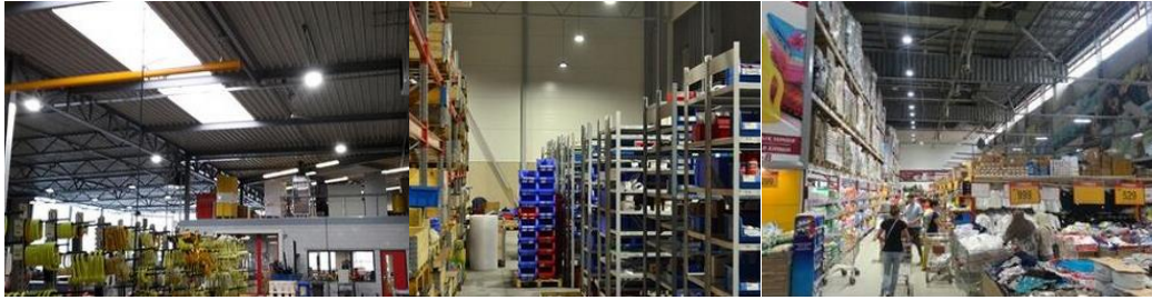
ภาพที่ 2 ตัวอย่างการประยุกต์ใช้งานของโคมฟลักซ์ไลท์ชนิดที่ใช้หลอดไฟแอลอีดี สำหรับใช้งานภายในอาคารเก็บสินค้าในโรงงาน หรือโกดังสินค้า
