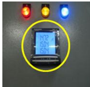
รูปที่ 18 ไฟแสดงสถานะไฟฟ้า และจอแสดงค่าทางไฟฟ้า (ปณต ศรีภักดิ์,2560)
