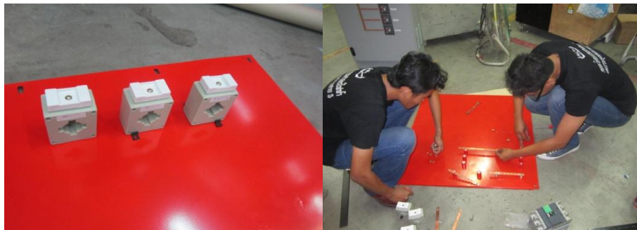
รูปที่ 12 ติดตั้ง CT และบัสบาร์ (ปณต ศรีภครีซต์,2560)
