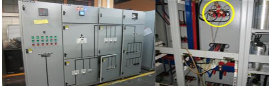
รูปที่ 17 การต่อสายไฟเข้าสู่ตู้สวิตช์บอร์ด (ปณต ศรีภักดิ์,2560)
