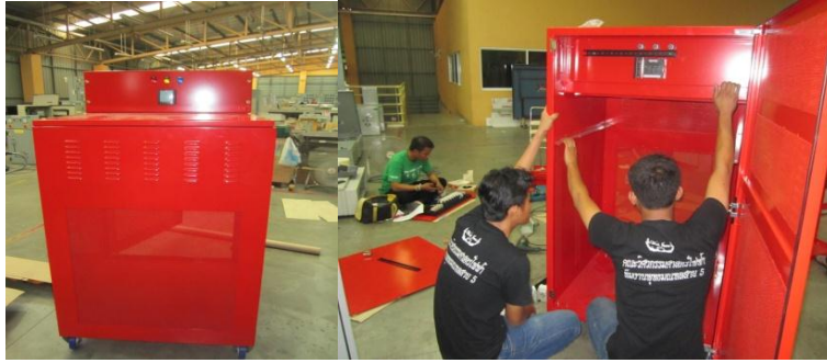
รูปที่ 10 ติดตั้งตู้ทดสอบโหลดเทียม (ปณต ศรีภครีซต์,2560)
