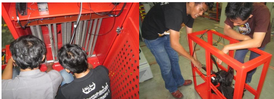
รูปที่ 13 ติดตั้ง ฮีตเตอร์ และพัดลมระบายความร้อน (ปณต ศรีภครีซต์,2560)
