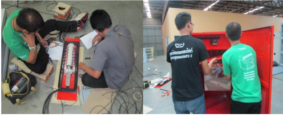
รูปที่ 14 เดินสายไฟคอนโทรล และประกอบแผ่นรับชุดคอนโทรล (ประยุกต์จาก [4]) (ปณต ศรีภักดิ์,2560)
