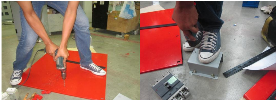
รูปที่ 11 เจาะรู และติดตั้งชุดเบรกเกอร์ (ปณต ศรีภครีซต์,2560)
