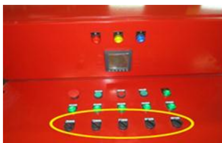
รูปที่ 19 Selector Switch Start and Stop (ปณต ศรีภักดิ์,2560)
