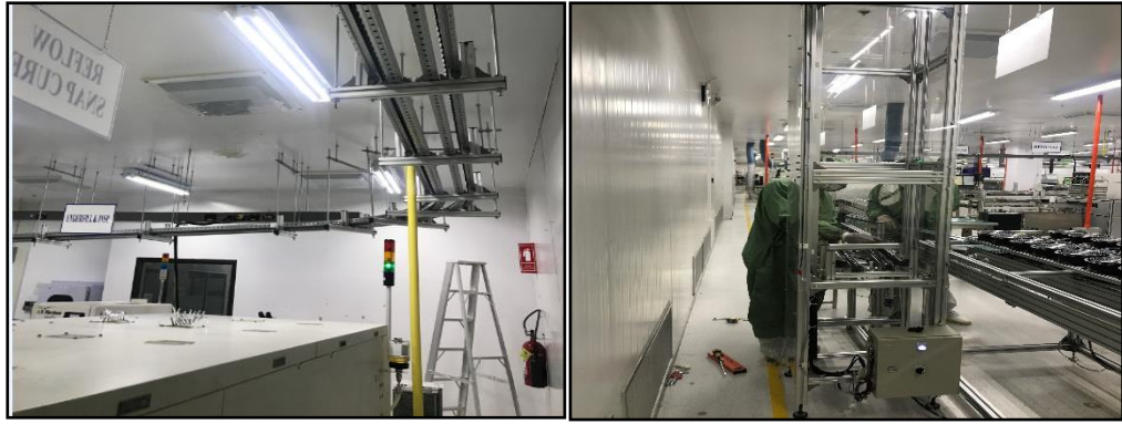
รูปที่ 6 การติดตั้งโครงสร้าง (ผดุงศิลป์ พิทักษ์, 2018)
