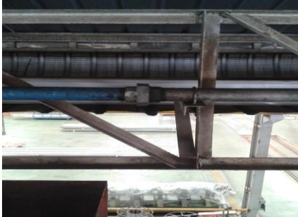
รูปที่ 10 ท่อยูเนียนแบบเดิม (สุมาลี อุไร, 2560)
