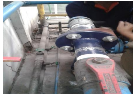
รูปที่ 13 ท่อที่ใช้จุดต่อเป็นหน้าแปลนหลังการปรับปรุง (สุมาลี อุไร, 2560)
