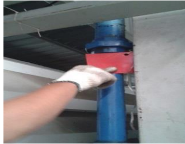
รูปที่ 9 ทำการสำรวจรอยรั่วของทอลม (สุมาลี อุไร, 2560)
