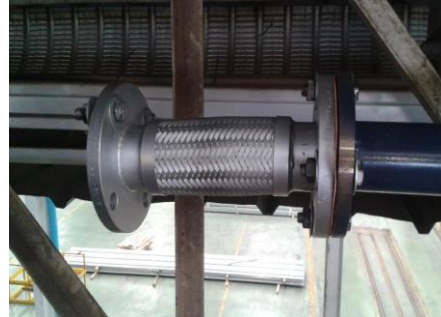
รูปที่ 11 ท่อเฟล็กซ์หลังทำการเปลี่ยนแปลง (สุมาลี อุไร, 2560)
