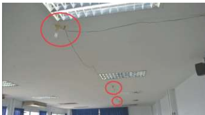
ภาพที่ 6 การติดตั้งหลอดไฟเพื่อใช้ในการทดลอง
